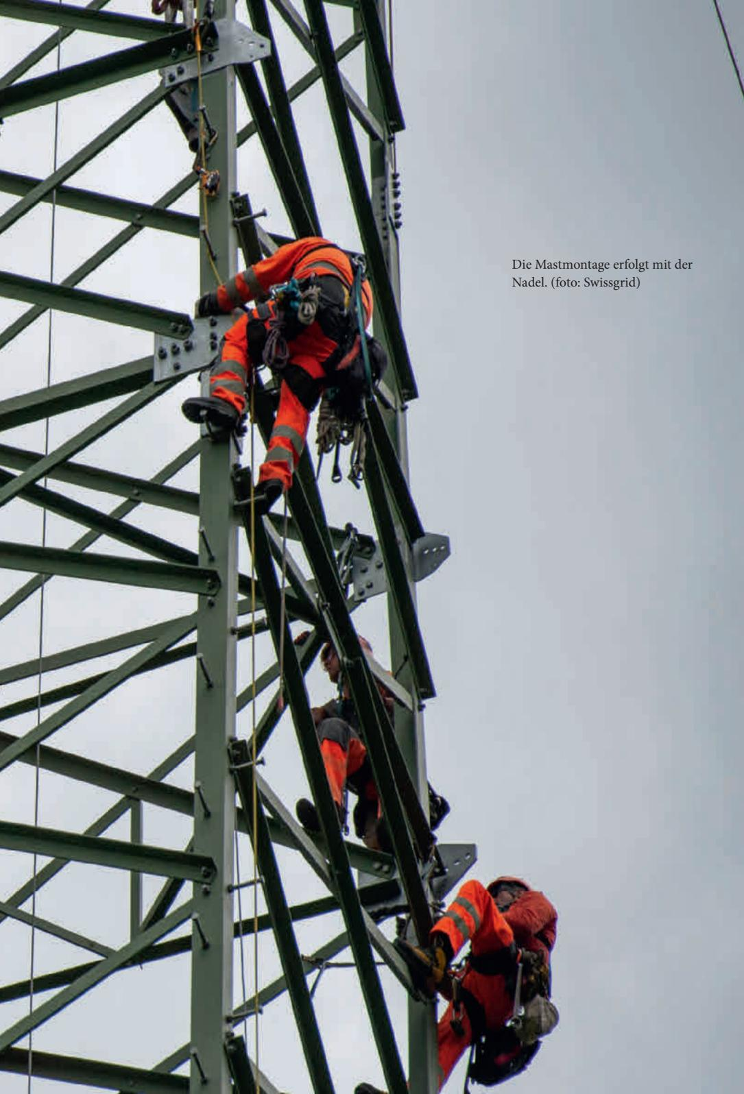
Die Mastmontage erfolgt mit der Nadel. (foto: Swissgrid)
