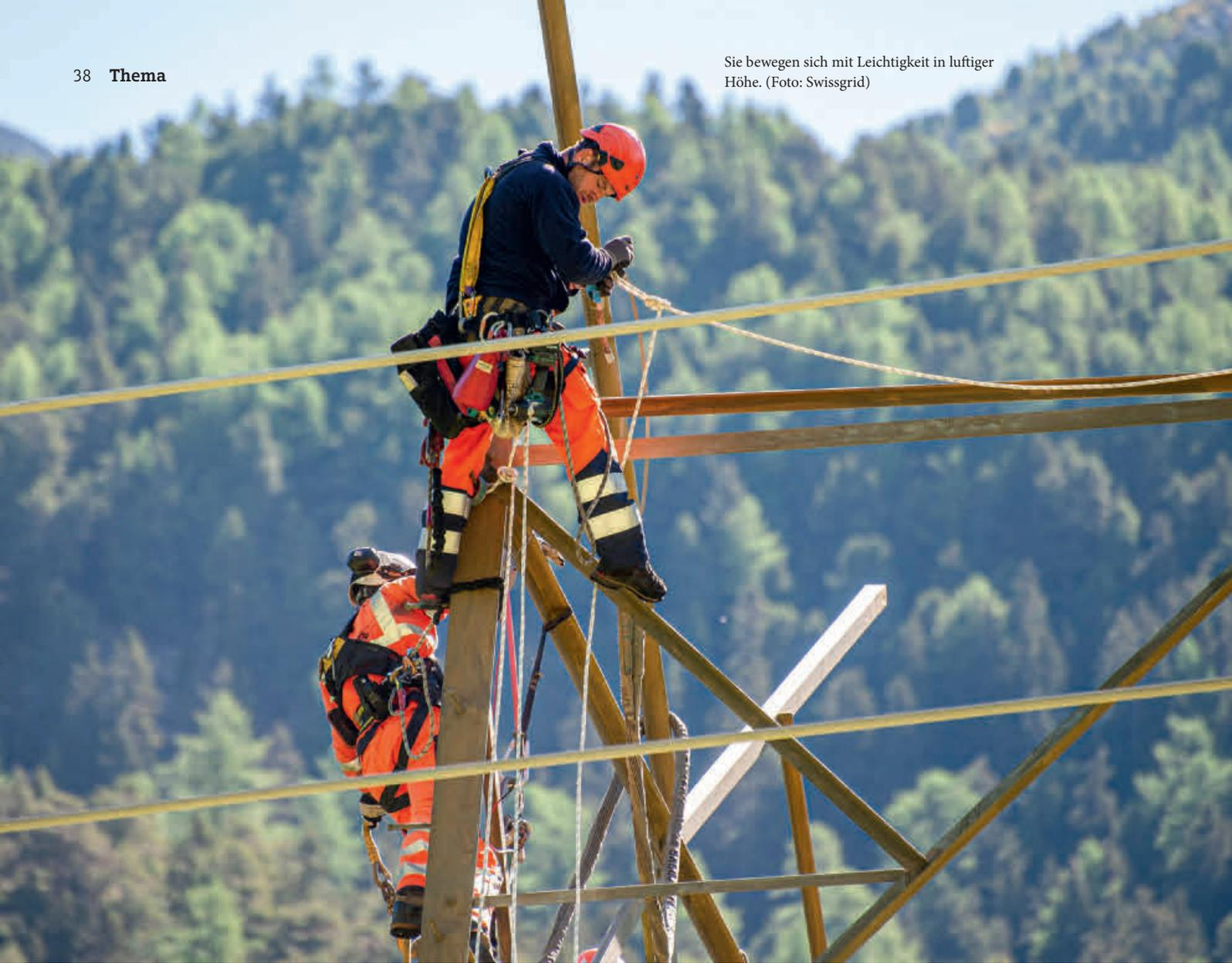
Schutzanstrich für alle Masten erstreckt sich über eine Fläche von 100'000 Quadratmetern. Denn ja, die Masten werden auch gestrichen. Allerdings erst ein Jahr nach dem Aufbau, damit die Grundierung bis dahin
