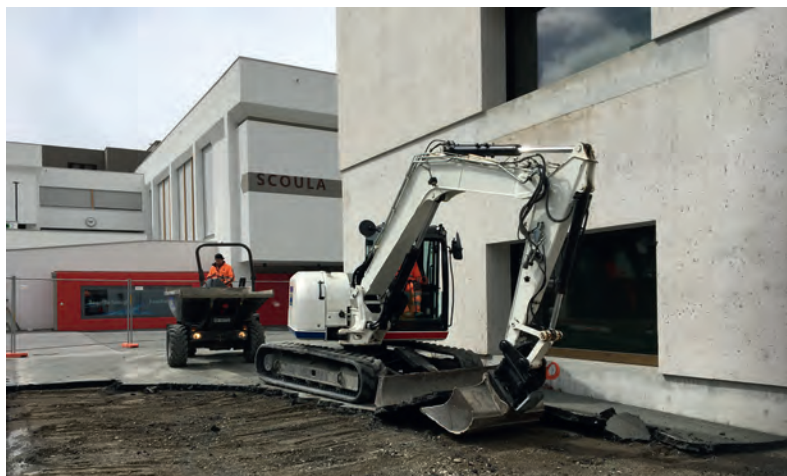
Dem Asphalt geht es an den Kragen.
