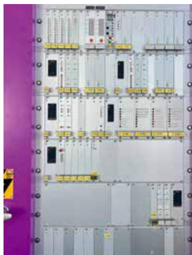
Der Schaltschrank des Sesselliftes Mot da Ri. Die schwarzen Felder sind die Melcher-Transformatoren. (Foto: Melcher)
